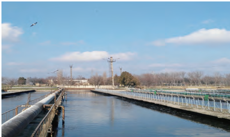
塔什干污水处理项目
